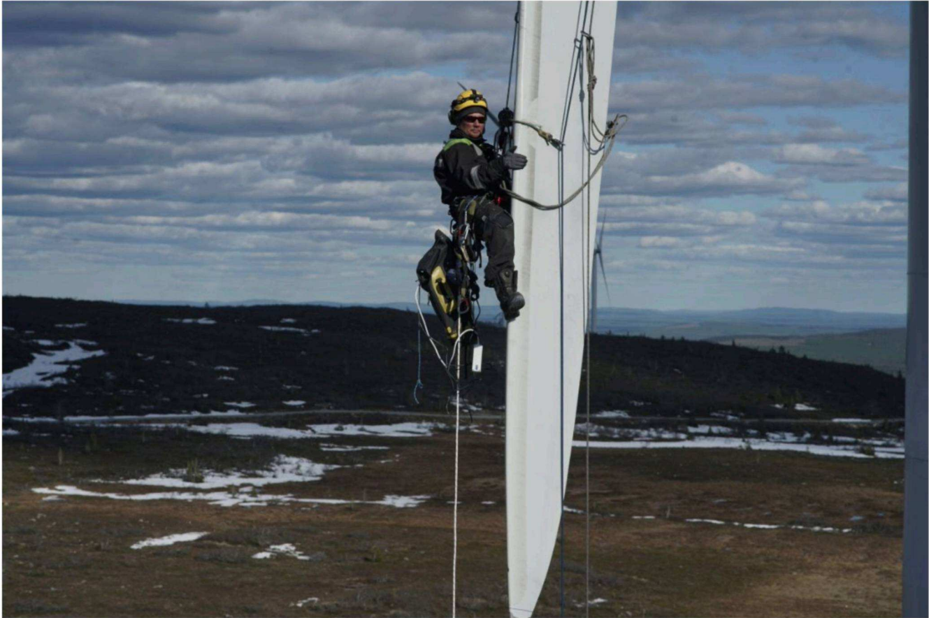
Greger Nilsson har den senaste tiden testat ett epoxylim som härdar i minusgrader för att laga skadade vingblad.
