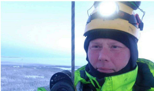
Greger Nilsson från Öjebyn lagar skadade vindkraftsblad med ett lim som härdar i minusgrader. Han tycker det är viktigt att lyfta fram att det inte bara är utländska företag som jobbar i vindkraftsbranschen i norra Sverige, foto: privat
