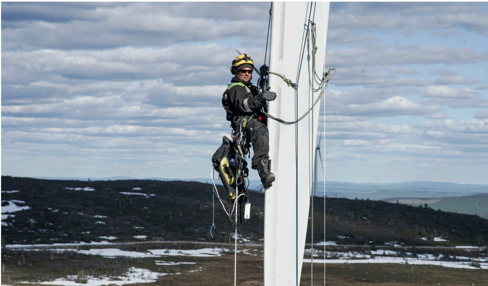
Isbildning på vindkraftverkens vingar utgör en utmaning för vindkraftsparkerna i norr. Greger Nilsson från Norrjärden driver bolaget Blade Solutions och har upfunnit metoder för att reparera
